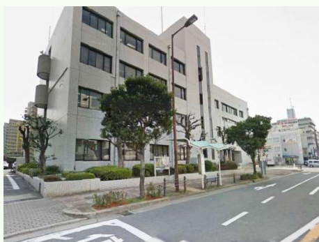
⇒④地下鉄横堤駅（鶴見警察前）
