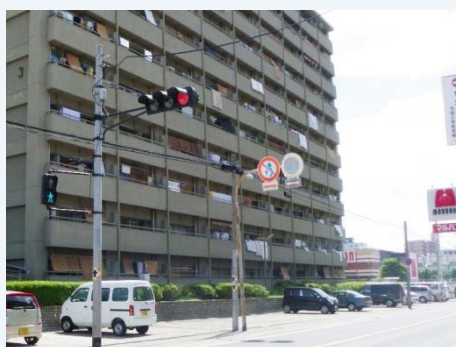
⇒②市営今福南住宅 3号館西側道路
